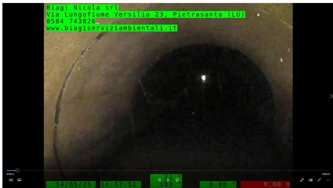
ISPEZIONE DELLA TUBAZIONE DA VIA ITALIA A VIA CAVOUR
